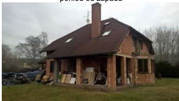
pohled od jihu
