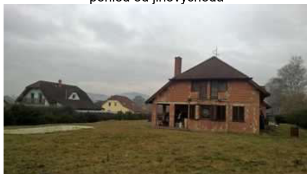
pohled od východu
